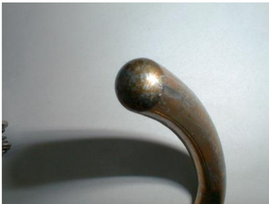
Styk ruchomy komory małosiejowej rozłącznika Fla 15/60 zdemontowanej po 15 latach pracy, podlega wymianie
