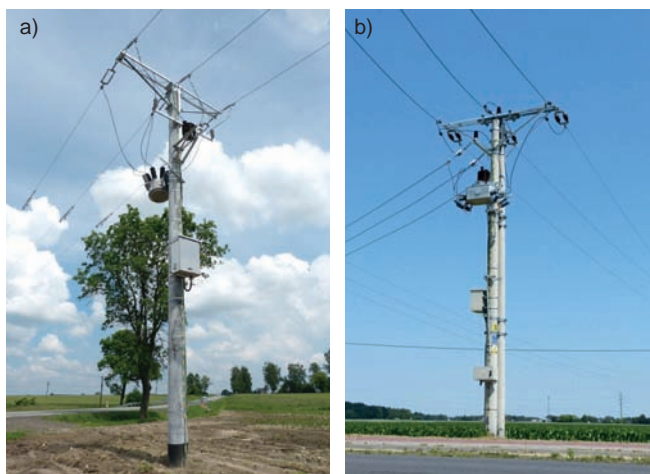
Rys. 7. Zdalnie sterowane łączniki budowy zamkniętej
